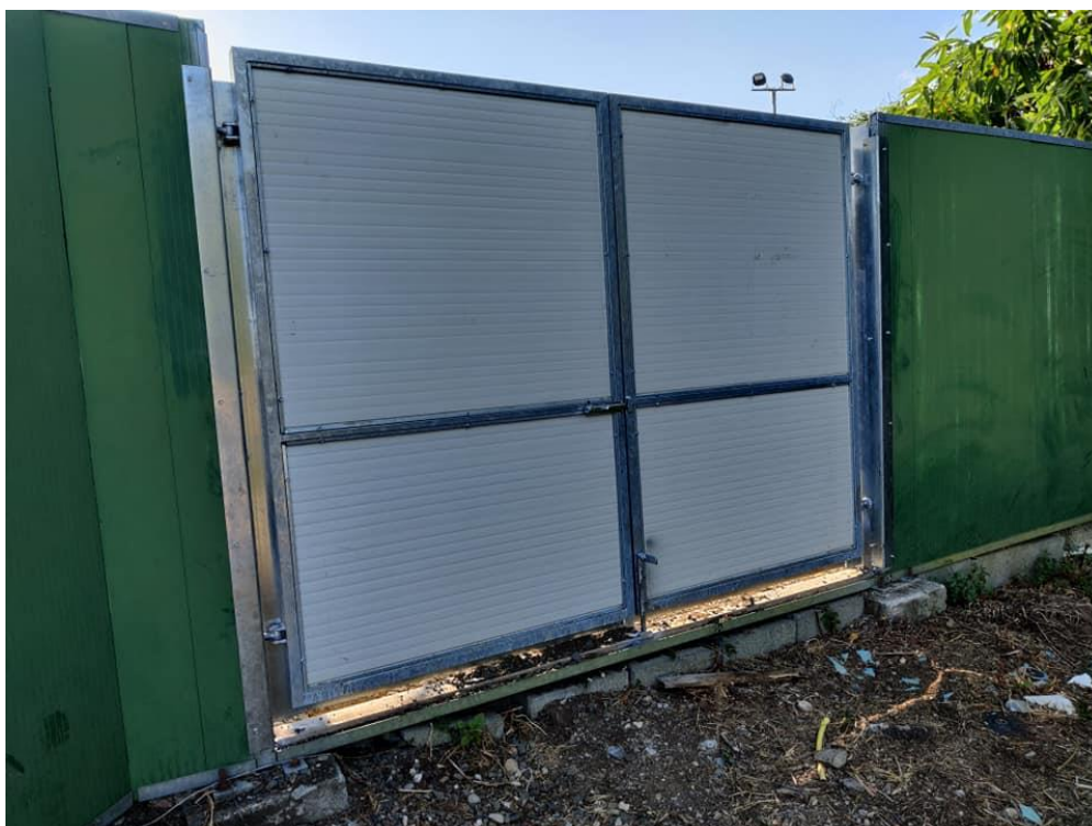
Il cancello del sesto sgambo per il passaggio dei mezzi di lavoro
