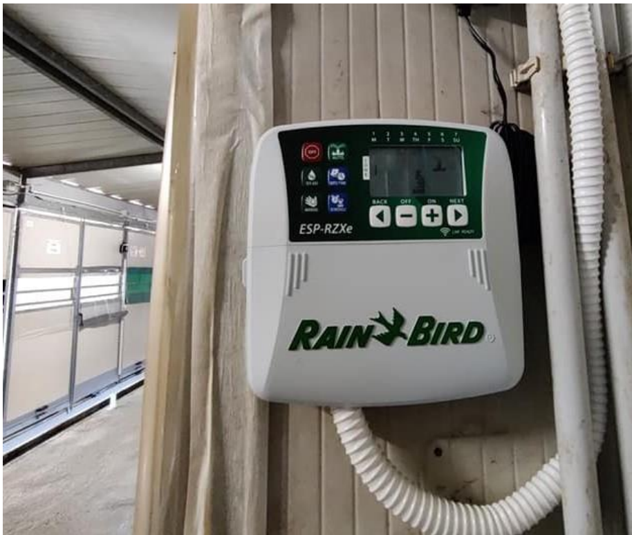
Il computer che programmato accende e spegne in autonomia l'impianto di nebulizzazione.
