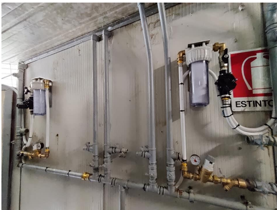
Il "cuore" dell'impianto con doppio filtro ed elettrovalvole.
